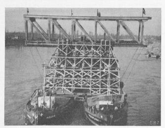
Bild 15. Ankunft der zweiten Brückenhälfte in Chalampé
