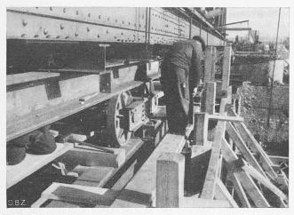
Bild 10. Auflagerung des MAN-Trägers auf den festen Verschubrollen des Schiffsgerüstes
