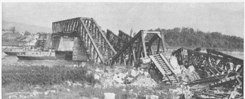
Bild 5. Brücke von Breisach nach der Zerstörung vom 2. 2. 1945, vom linken Ufer aus gesehen
