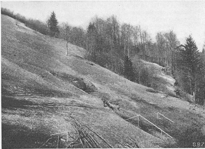
Bild 2. Abgesteckte neue Militärstrasse bei Giswil, Obwalden. Entwässerungsgraben
