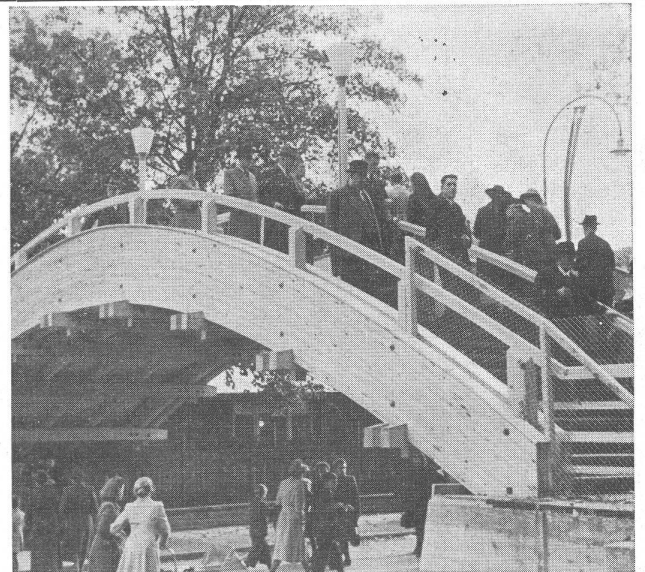
Strassenüberführung OLMA St. Gallen 1944 Ersteller: Osterwald & Bischof, St. Gallen
