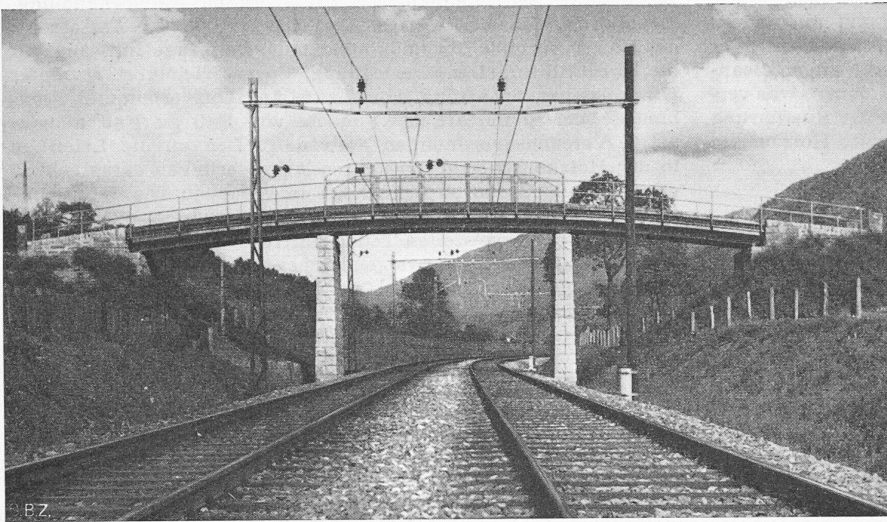
Bild 27. Strassenüberführung bei Km. 167,520 Rivera-Taverne
