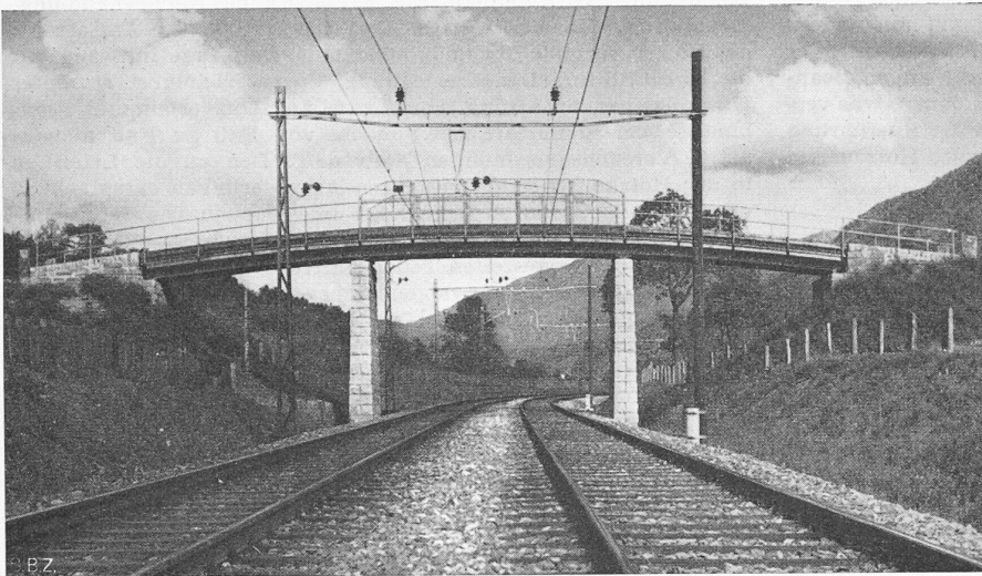
Bild 27. Strassenüberführung bei Km. 167,520 Rivera-Taverne
