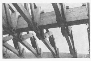
Bild 23. Spanten und Längsträger-Durchdringung
