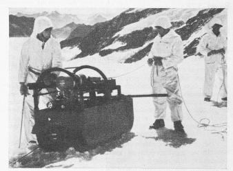
Bild 4. Motorschlittenwinde Typ M. S. W.
