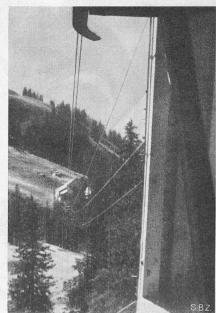
Bild 7. Ausschnittt einer aus drei L. U.-Einheiten zusammengestellten, 6 km langen Bahn. Zwischenstation als Alphütte mit zur Bahnaxe abgedrehtem First, keine Waldschneisen
