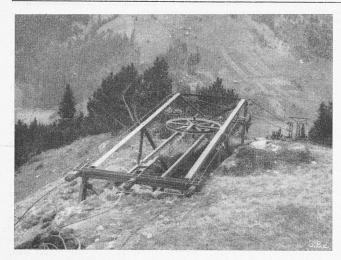
Bild 3. Seilbahntyp L. P., Spanngestell vor der Tarnung. Ganz vorn links der eingegrabene Schwergewichtskasten
