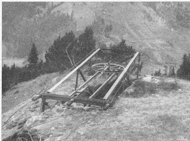
Bild 3. Seilbahntyp L. P., Spanngestell vor der Tarnung. Ganz vorn links der eingegrabene Schwergewichtskasten
