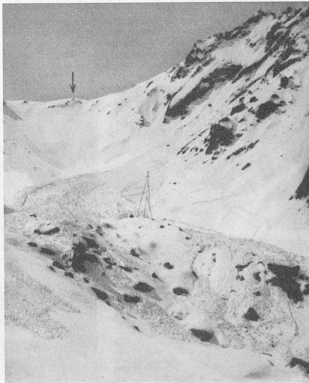
Bild 2. Typ S. P. überspannt in Mastentfernungen von 1000 m und mehr lawinengefährdete Abschnitte. Die Bahn überquert in einem nach oben gedeckten Einschnitt den Höhenkamm
