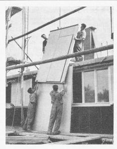
Bild 2. Innenwandelemente für das Obergeschoss
