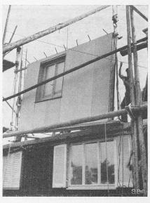
Bild 3. Aufziehen eines Aussenwandelementes
