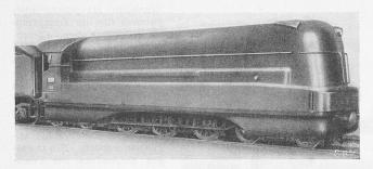
Bild 20. Ansicht der Lokomotive mit Verschalung
