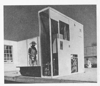
Bild 10. Wandelement mit fertig eingebauter Installation
