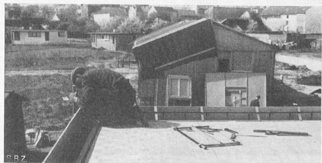
Bild 5. Schweizerhaus im Bau, hinten schwedisches Holzhaus
