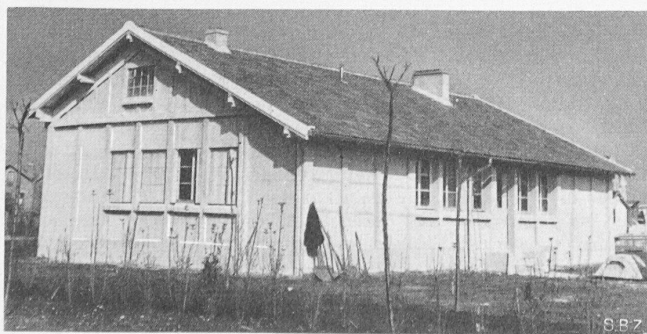
Bild 4. Maison «Jeep», Eisenbetonelemente
