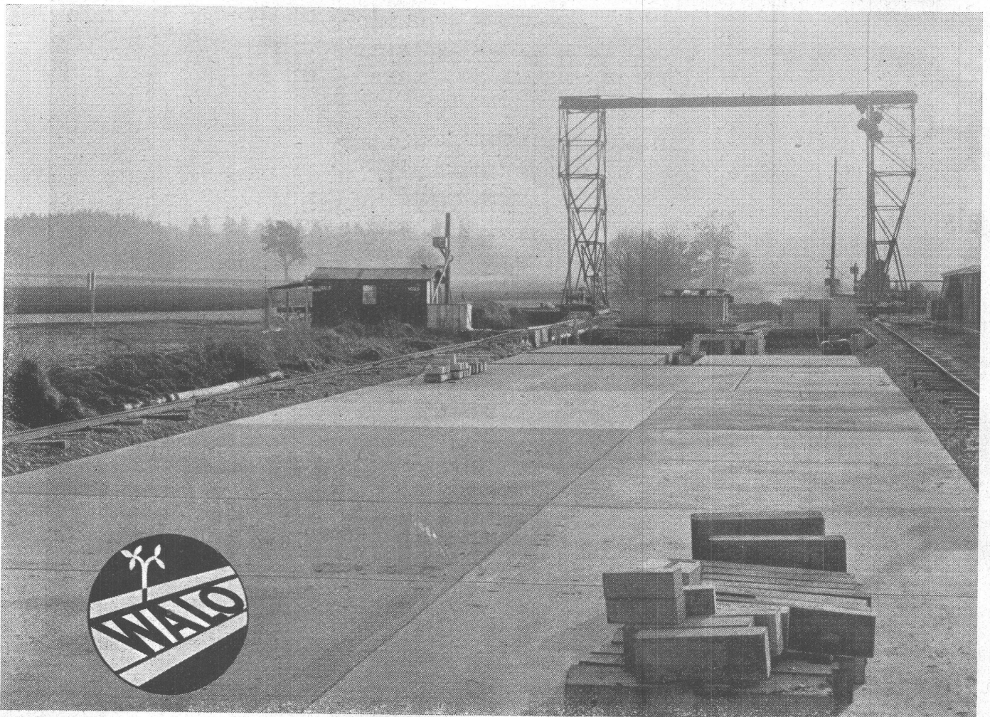
Bau der Versuchspiste in Kloten
