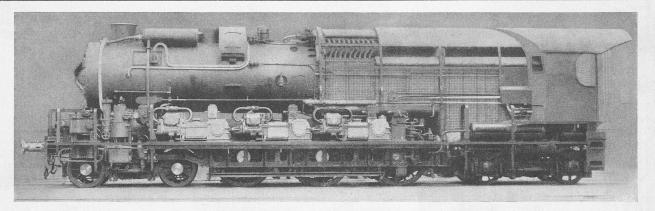
Bild 1. 2-Co-2 Einzelachs-Hochdruck-Lokomotive der SLM für die französische Staatsbahn, mit abgenommener Stromlinienverschalung
