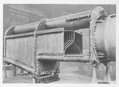
Bild 4. Kessel der 3300 PS-Hochdruck-Lokomotive. Feuerbüchse, Verbrennungskammer, Ueberhitzerraum
