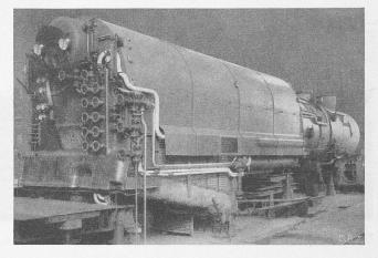
Bild 12. Kessel bereit zur Anheizprobe in der Werkstätte
