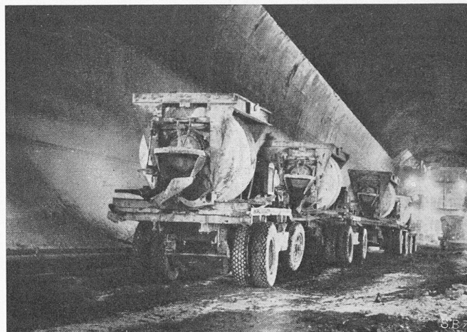
Bild 16. Gleisfreier Betontransport in einem Stollen des Boulder-Kraftwerkes, U. S. A., 1932. Stollendurchmesser 15 m
