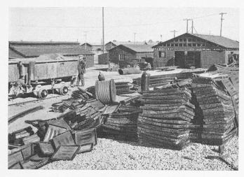
Bild 18. Gepresste Stahlplatten für den Einbau beim Colorado-River-Aquaedukt. Im Hintergrund A. L. Sonderegger, Dipl. Ing. E. T. H., Grundwasserexperte
