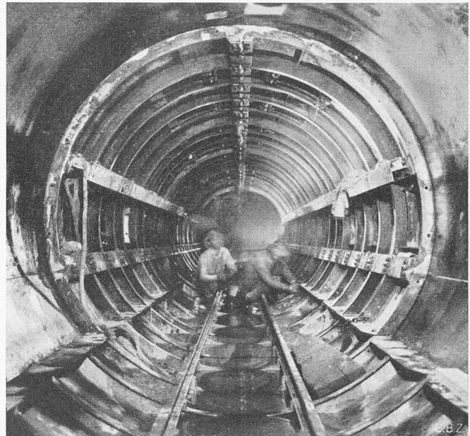
Bild 20. Blaw-Knox Stahlschalung in einem Stollen des Bouquet-Reservoir in Kalifornien
