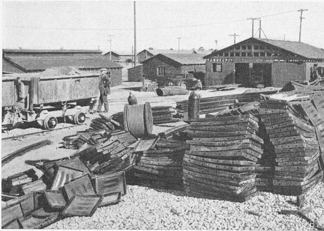
Bild 18. Gepresste Stahlplatten für den Einbau beim Colorado-River-Aquaedukt. Im Hintergrund A. L. Sonderegger, Dipl. Ing. E. T. H., Grundwasserexperte
