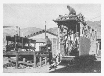
Bild 10. Dreistöckiger Bohrwagen vom Bau des Colorado-River-Aquaedukts, U.S. A.
