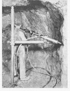
Bild 7. Bohrhammer auf pneumat. Säule
