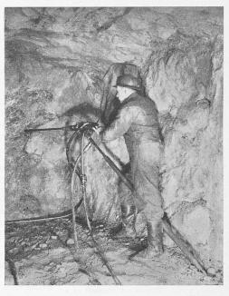
Bild 8. Bohrhammer mit Knievorschub
