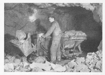
Bild 12. Lademaschine «Atlas-Diesel» mit Schaufel für ½ m³
