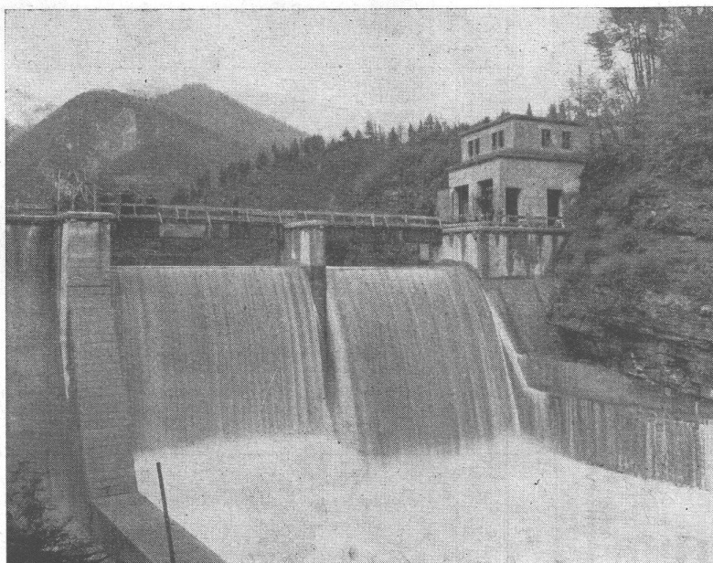
Zwei automatische Stauklappen, je 12,25 m breit und 4,50 m hoch, auf dem Wehr im Cordevole der Società Adriatica di Elettricità, Venezia.
