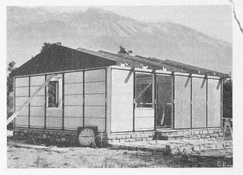
Bild 2. Probehaus Nr. 1, Zustand  $2^{i}l_{i}$  Stunden nach Montagebeginn. Anticorodalrahmen mit schwarzem Bitumenlack gestrichen
