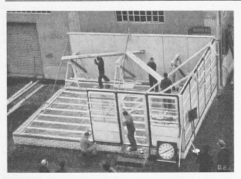
Bild 1. Montage des Probehauses Nr. 2 in Zürich. Zustand 35 Minuten nach Montagebeginn
