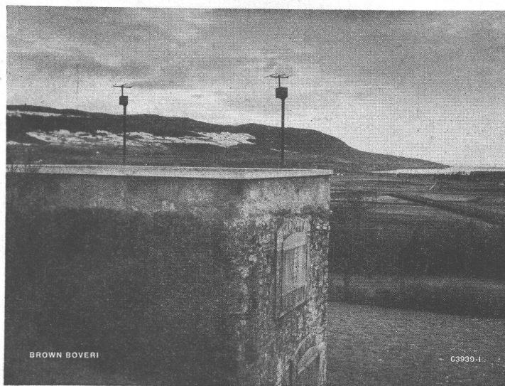
Drahtlose Telefonie-, Fernmess- und Fernsteueranlage für die Wasserversorgung der Gemeinde Yverdon. Die Uebertragung ist mit einfachen Dezimeterwellen-Funkgeräten zwischen Reservoir, Pumpstation und Ueberwachungsstelle möglich. Auf dem Dach des Reservoirs sind die aufgebauten Richtantennen zu erkennen.
