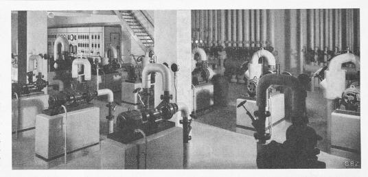
Bild 44. Wärmezentrale mit Zirkulationspumpen, hinten links Schalttafel, rechts Verteilbatterie
