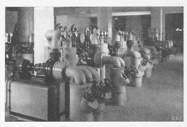
Bild 46. Wärmezentrale mit Heisswasser-Zirkulationspumpen
