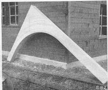
Bild 5. Fertige Binderhälfte
