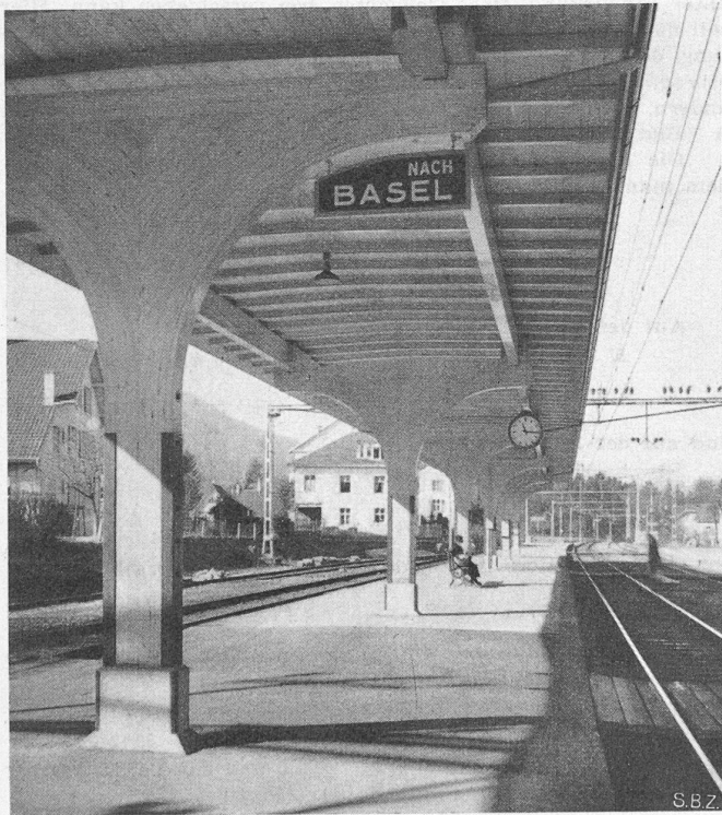
Bild 10. Perrondach in Sissach, Ansicht von unten
