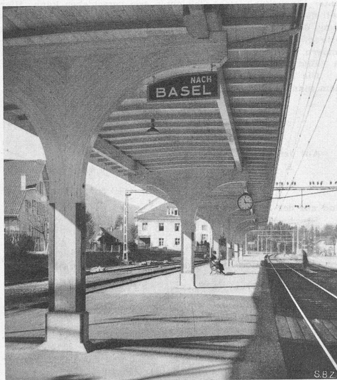
Bild 10. Perrondach in Sissach, Ansicht von unten
