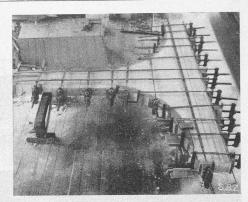
Bild 6. Verleimen der obern Zuglamellen
