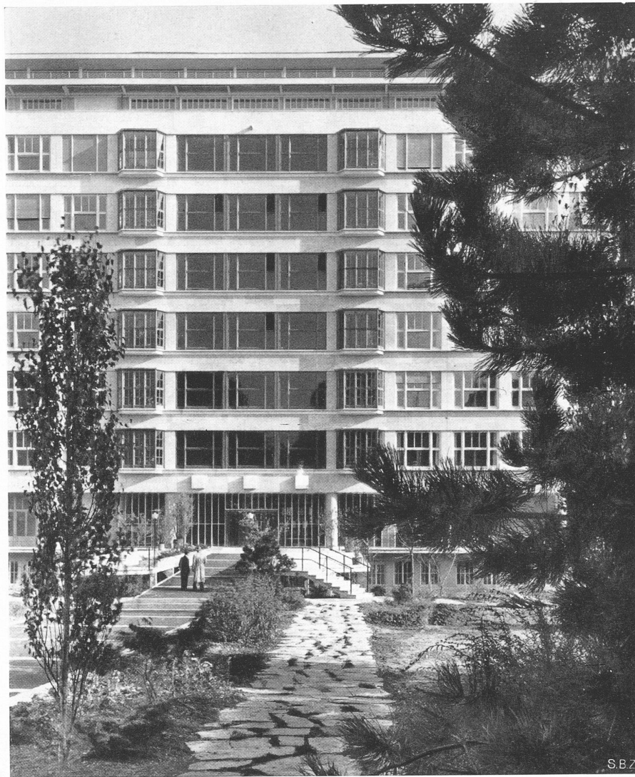
Bettenhaus, Mittelpartie der Gartenfassade
