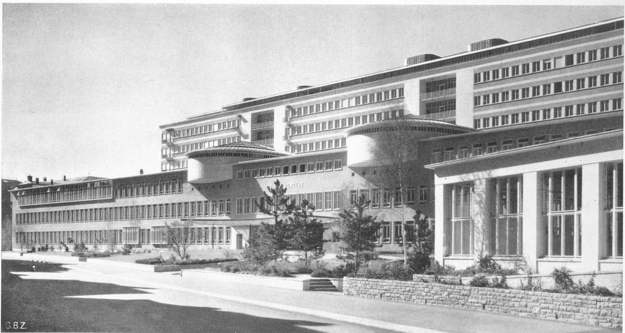
Behandlungsbau aus Norden, dahinter das Bettenhaus, rechts Hauptküche
