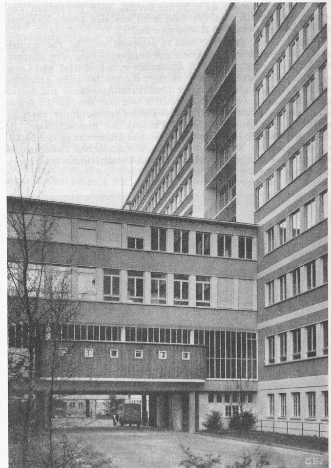
Bild 12. Hof u. Zwischenbau 3, Vorfahrt Krankenannahme im 1. U.-Geschoss
