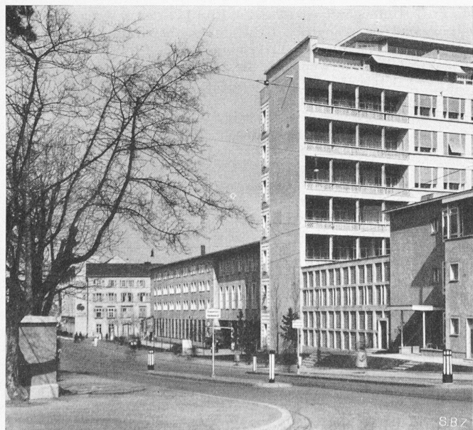
Bild 6. Westende des Bettenhauses an der Schanzenstrasse, rechts davon Lärmschutz-Wand und Infektionskrankenhaus, links Küchenbau
