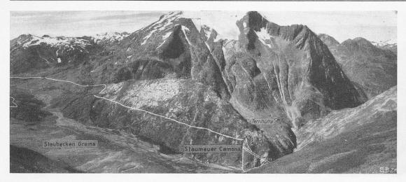
Bild 6. Greinabecken mit Sperrstelle von Ost nach West gesehen. Links neben der Terrihütte Schuttkegel für Betonkies
