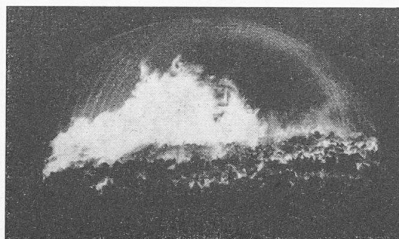
Bild 22. Halbseitig beschickter Planrost
