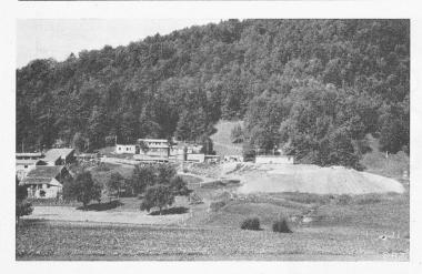
Bild 13. Kohlenbergwerk Riedhof Aeugst. Links: Sieb- und Sortieranlage, Mitte: Bureau, Werkstätten, Stolleneingang, anschliessend Deponie
