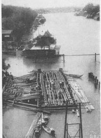
Bild 10. Provisorischer Boden für den Brunnen um Pfeiler C
