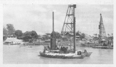
Bild 5. Rammen eines Holzpfahls (vorn) und eines Eisenbetonpfahls (hinten)
