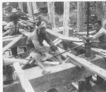
Bild 12. Hochziehen des oberen Teils des Eisenbetonbrunnens bei Pfeiler D
