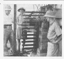
Bild 27. Vorspannen der Zugbänder; Dehnungskontrolle mit Stoppanimeter
