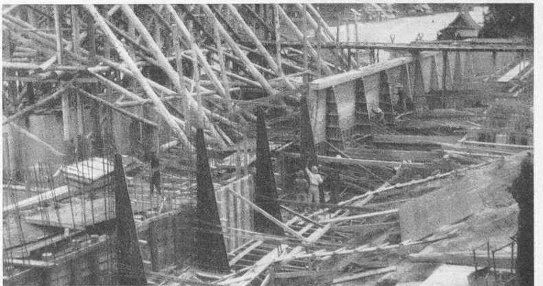
Bild 8. Stützmauer Westufer im Bau, links Pfeiler D
