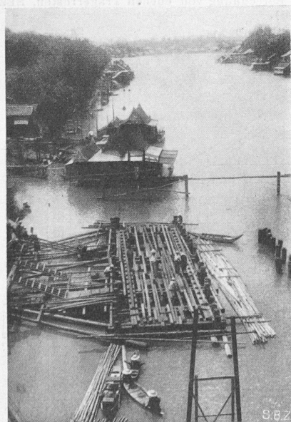
Bild 10. Provisorischer Boden für den Brunnen um Pfeiler C
