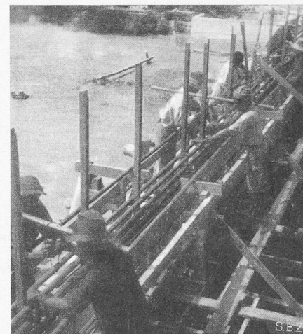
Bild 16. Verlegen der Zugbandeisen
