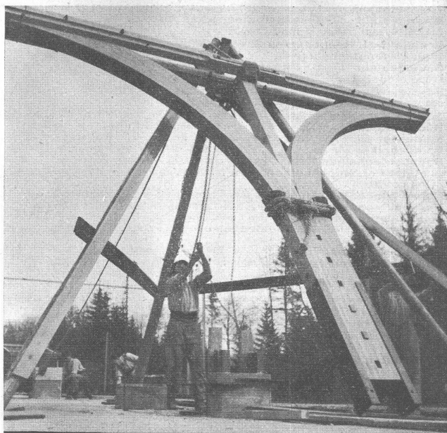
Hetzerträger für Perrondach Bahnhof Ramsei Ersteller: Firma Gribi & Co. A.G., Burgdorf
