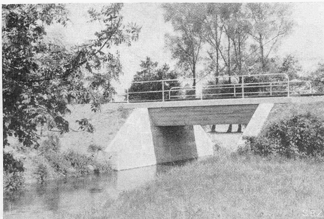
Abb. 11. Eisenbetonbrücke über den Oeschbach bei Subingen Stützweite 6,0 m
