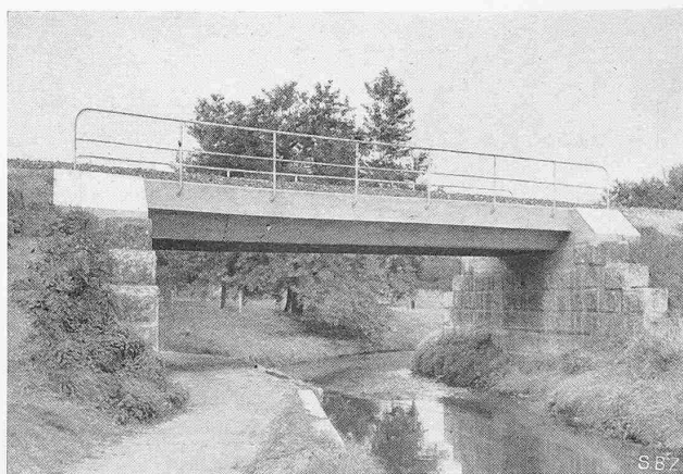
Abb. 12. Eichibachbrücke bei Dotzigen, Stützweite 12,4 m, schief 60°
