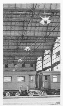
Abb. 24. Schallstrahler in einer Bahnhofhalle
