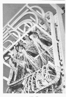
Zentrale einer elektroakustischen Grossanlage: Abb. 25 Relaisgestell und drei Verstärkergestelle; Abb. 26 Rückansicht davon Abb. 27 Abgedecktes Relaisgestell mit einer Haupt- und sieben Nebenstellen und mehreren Lautsprechergruppen Abb. 28 Einführung der Tonfrequenzkabel- und Signalleitungen in das Relaisgestell
