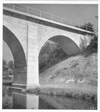
Abb. 4. Teilansicht der umgebauten Oenzbrücke; Verkleidungsmauerwerk der Gewölbestirnkränze und Aufbauten
