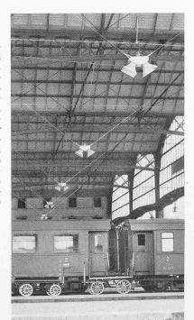
Abb. 24. Schallstrahler in einer Bahnhofhalle
