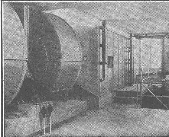
Konditionierungsaggregate zur Klimaanlage
