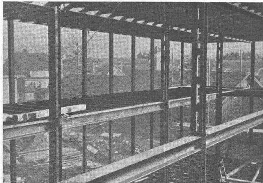
**Stahlskelette** für Industriebauten
