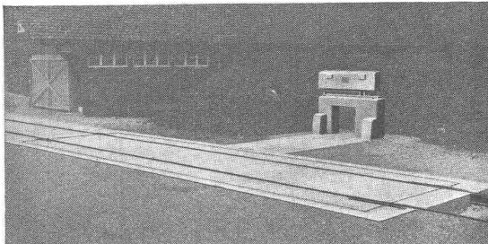
40t Geleisewaage mit armierter Betonbrücke, pat. Auffahrrampen, torsionsfreien Hebelen und verstellbaren Schneiden
