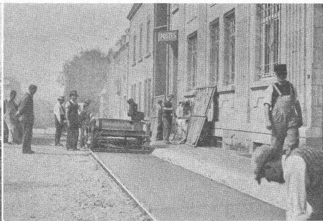
**Auto-Strassen und Gross-Pisten** in ganzer Breite von 9 Meter hergestellt. Der Fertiger verteilt, verdichtet und glättet den Beton in einem einzigen Arbeitsgang.
