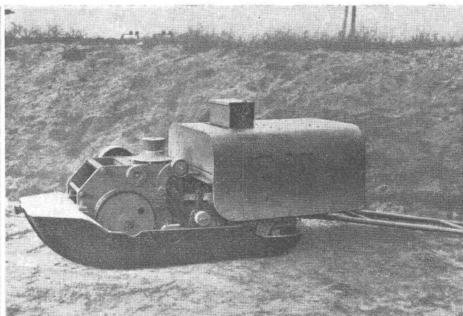
**Betonverteiler**, welcher direkt durch Lastwagen gespeist wird. Durch die Wiederauflockerung des Betons beim Verteilen kann der Beton in einer Mischzentrale, **viele Kilometer weit vom Arbeitsplatz entfernt**, hergestellt werden.
