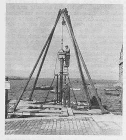
Abb. 2. Montage des 4 m hohen Einlaufbauwerks, das am äussern Ende der Seeleitung montiert, zusammen mit dieser auf den Seeboden in 30 m Tiefe versenkt worden ist
