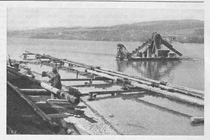
Abb. 3. Zusammensetzen der mit geteerter Jutewicklung gegen Korrosion geschützten Mannesmannrohre von 200 mm Durchmesser und Umwickeln der Muffenverbindungen mit Densobinden
