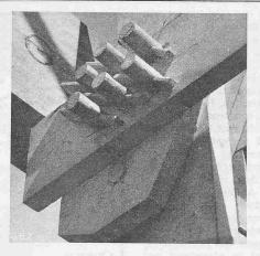
Abb. 1. Die Holzzapfen mit ihren Keilen Abb. 2 (rechts). Endauflager des Holzfachwerkträgers
