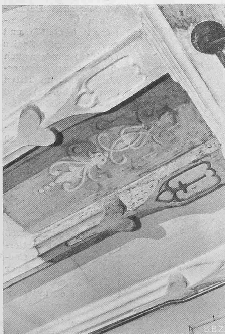
Abb. 19. Freilegen der Deckenmalerei
