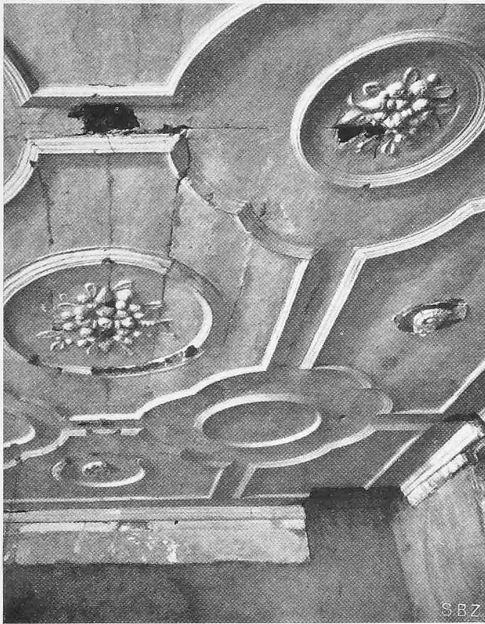
Abb. 15. Stuckdecke vor der Renovation
