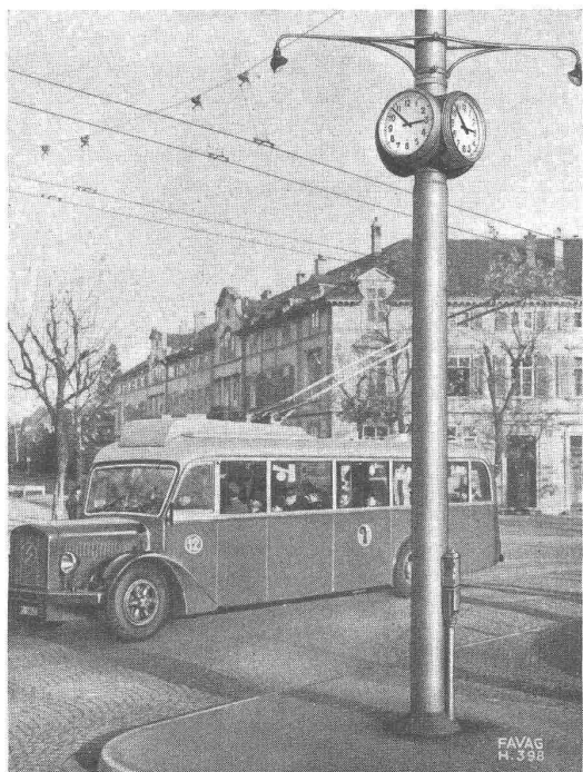
Horloge à quatre faces de Ø 60 cm d'un grand réseau urbain comprenant plus de 1000 horloges secondaires, commandées par une centrale horaire de 20 lignes.
