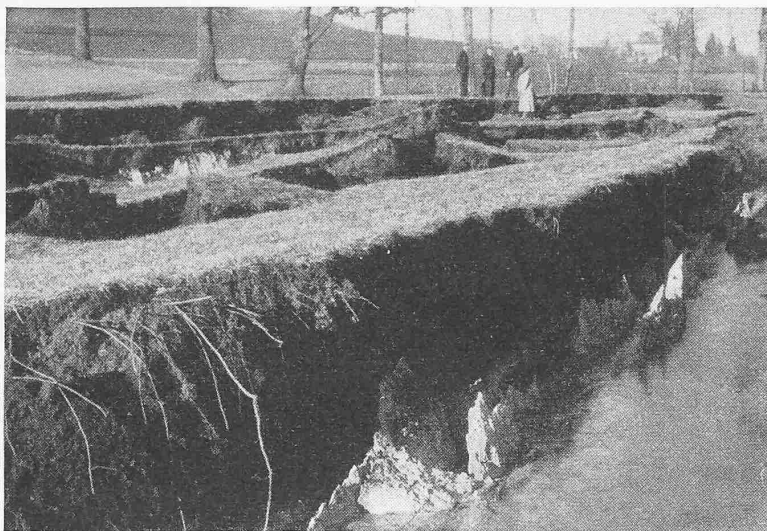
Abb. 3. Spaltenbildung in der Einbruchzone. Einzelne Schollen sind schwach gegen die Landseite geneigt. Unter Humus und Torf ist die weisse Seekreide deutlich sichtbar; sie ist von senkrechten Scherflächen durchsetzt
