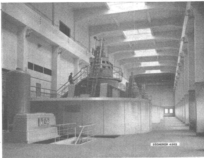
Elektrizitätswerk Genf, Kraftwerk Verbois. 3 Dreiphasen-Generatoren 27 500 kVA, 18 000 V, 50 Per/s, 136 U/min (Durchbrenntourenzahl 310 U/min) in vollständig geschweisster Ausführung.
