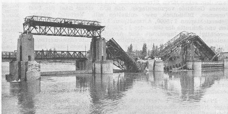
Abb. 3. Stauwehr Kembs vom Oberwasser aus, Öffnung 2 (am wenigsten beschädigt), Öffnung 3, 4 u. 5. Aufbau Pfeiler III und Widerlager rechts durch Sprengung zerstört. Windwerks- und Strassenbrücke eingestürzt, Öffnung 5 oberwasserseitige Dammbalken eingesetzt. Unterwasserseitig Kriegsnotbrücke
