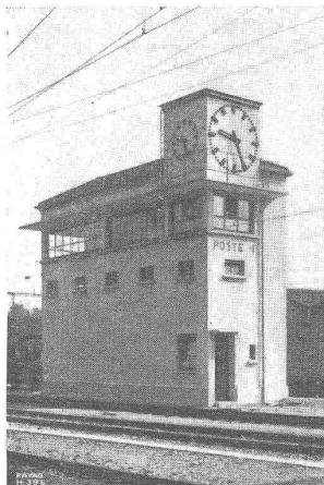
Weichenstellwerk eines Hauptbahnhofes, ausgerüstet mit drei elektrischen Uhren von 150 und 250 cm Ø. Beleuchtete Zeiger und Stundenstriche.
