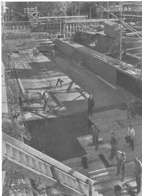
Hallen-Schwimmbad Zürich Wasserdichte Isolation der Kellerräume gegen Grundwasser mit unserem bewährten System „MAMMUT“
