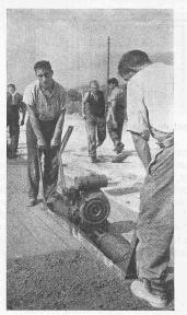
Abb. 12. Vibrationsgerät
