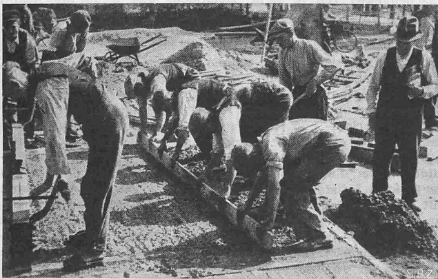
Abb. 10. Verdichtung von Hand
