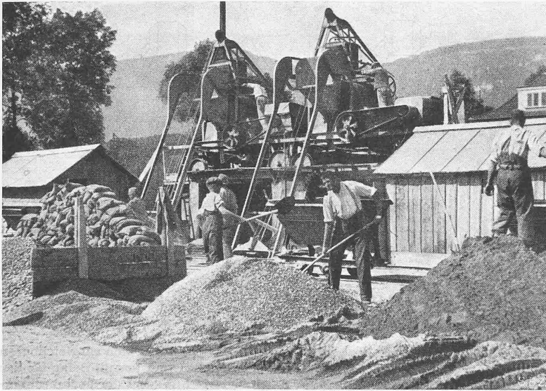
Abb. 13. Ortfeste Betonaufbereitungsanlage beim Strassenbau Solothurn-Selzach
