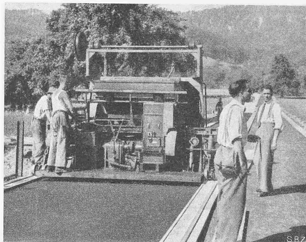
Abb. 1. Einbau eines 3 cm starken Teerasphalt-Betons (Sparbelag) in Langnau am Albis mit Strassenfertiger Raco, System Waldvogel, im Sommer 1944 durch die Firma Gebr. Krämer, Zürich
