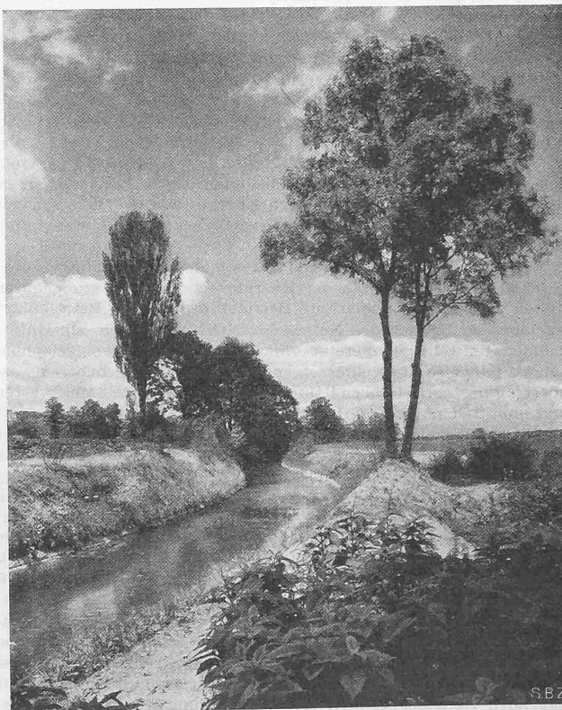
Abb. 4. Durch leichte Schmiegun des Laufes und Schonung der Vegetation fügt sich auch ein korrigierter Bachlauf ins Landschaftsbild
