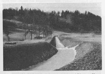
Abb. 3. Alte Schule, Gegenbeispiel: in Grundriss und Längenprofil schematische, rücksichtslose Trassierung einer Bachkorrektion
