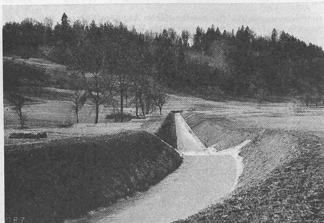
Abb. 3. Alte Schule, Gegenbeispiel: in Grundriss und Längensprofil schematische, rücksichtslose Trassierung einer Bachkorrektur
