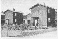
Abb. 1 bis 4. Ob 16. oder 20. Jahrhundert, ob Bruchstein, Holz oder Backstein, die homogene Wand führt in reiner Anwendung zur blockhaften, geschlossenen Bauform, in der die Fenster als einzelne Oeffnungen sitzen
