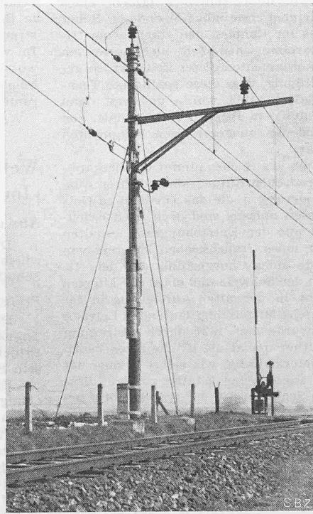
Abb. 12. Nachspanngewichte am Abspannmast
