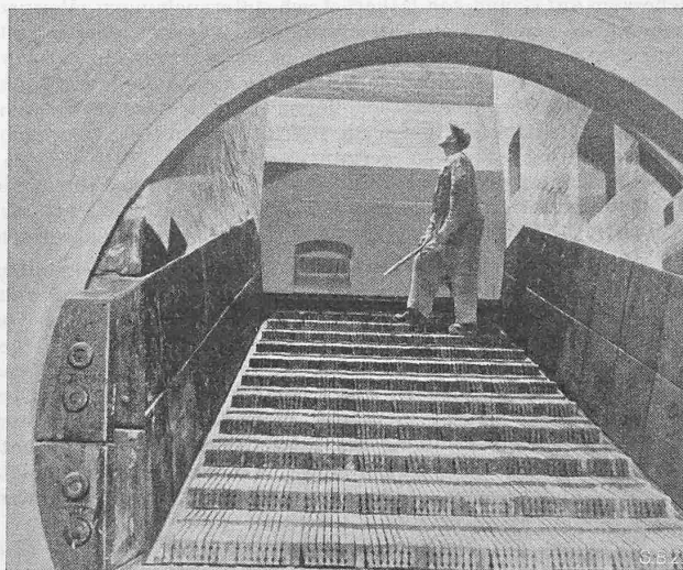
Abb. 7. Der Anzünd-Rost (5 in Abb. 3)
