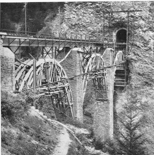
Abb. 34. Bauzustand nach Abbruch der Gewölbe und Hochführung der Pfeiler 1 und 2. Beginn des Lehrgerüstabbruchs
