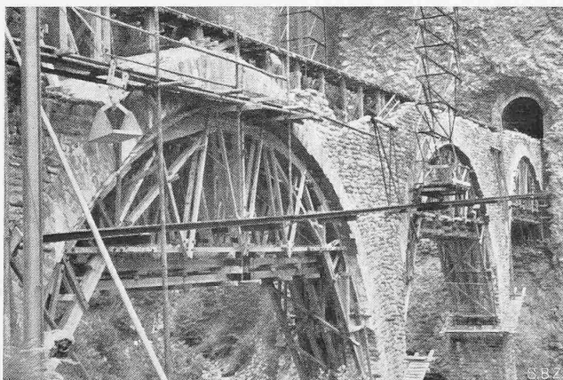
Abb. 25. Abbruch der Stirnmauern, dazwischen das Stempelgerüst
