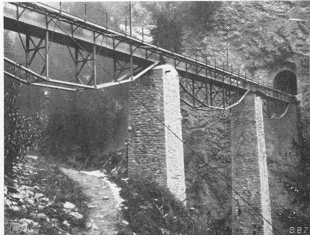
Abb. 20. Der umgebaute Viadukt mit drei einfachen Blechbalken
