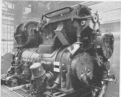
Abb. 8. BBC-Thermobloc auf dem Versuchstand in Baden
