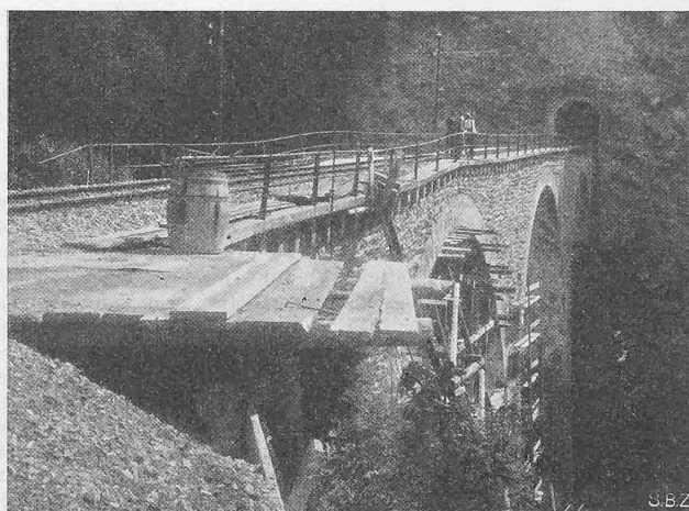
Abb. 2. Zustand zu Beginn der ersten Verstärkungen (1930)
